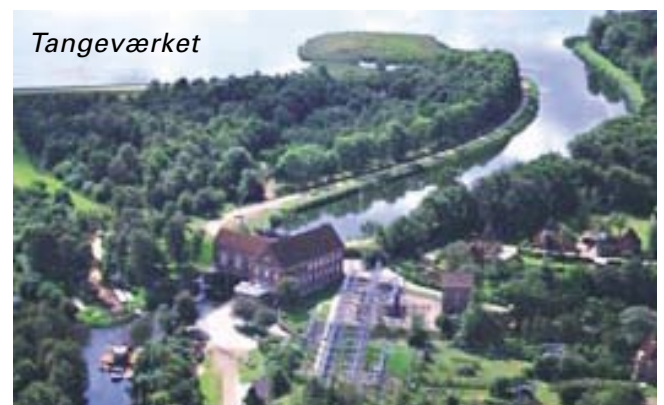
På Tangeværket ved Gudenaåen har man produceret elektricitet med vandkraft siden 1921
