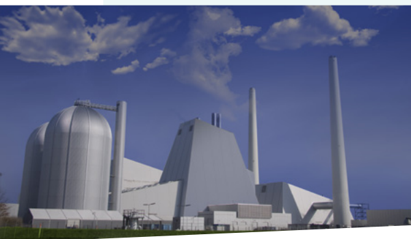
Avedøreværket i Hvidovre
