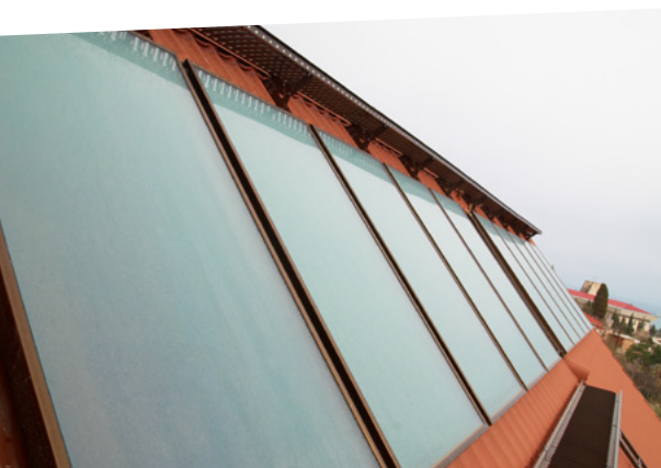
Solvarmeanlæg ligner solceller en del, men her løber der varmt vand inde bag den mørke plade.
