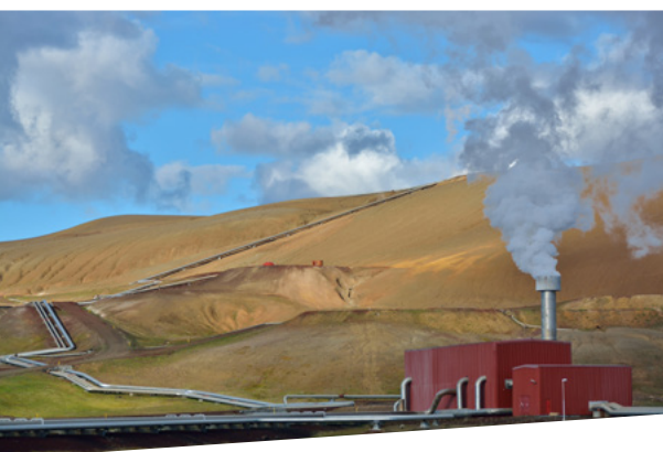
Geotermisk anlæg på Island.
