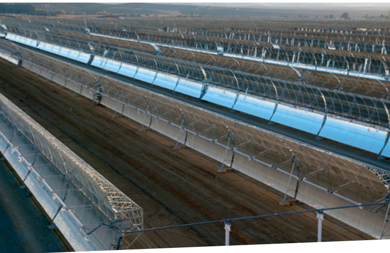
U-formede spejle sender solstrålerne mod et oliefyldt rør.
