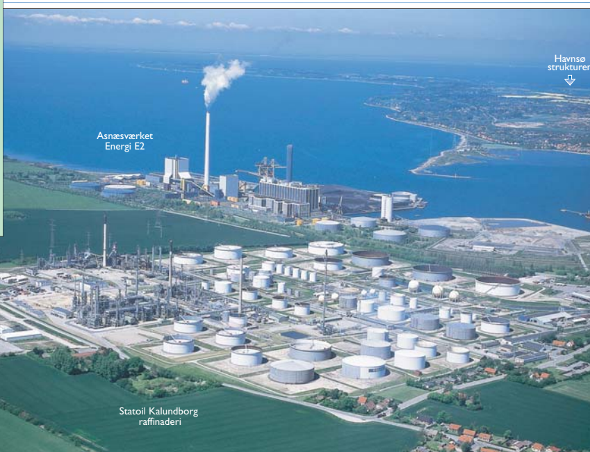
Asnæsværket og Statoils olieraffinaderi ved Kalundborg. Foto: Energi E2.
