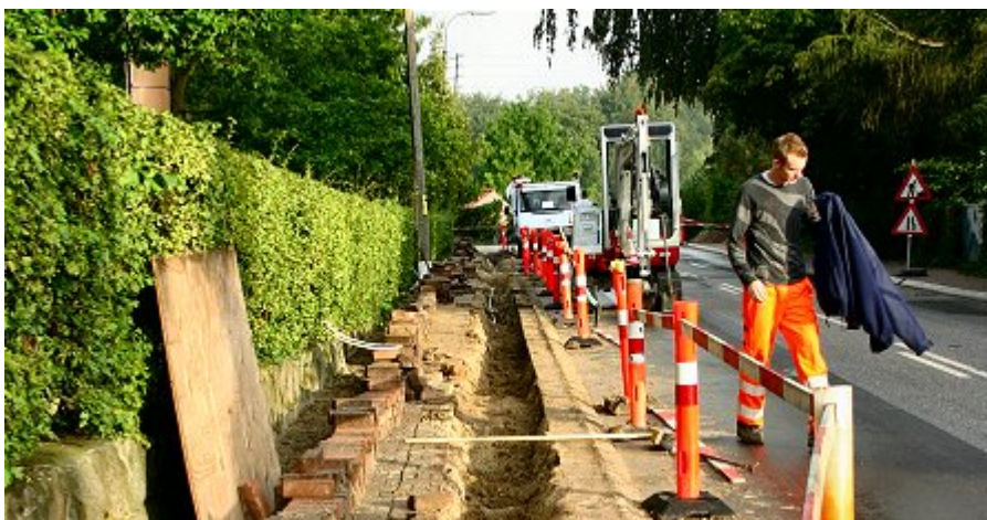
El-ledninger falder ned, men efter decemberorkanen i 1999 er kabellægning af el-distributionsnettet fremskyndet, og det forventes at være fuldt kabellagt inden for de næste ti år. Foto Niels Hansen.
