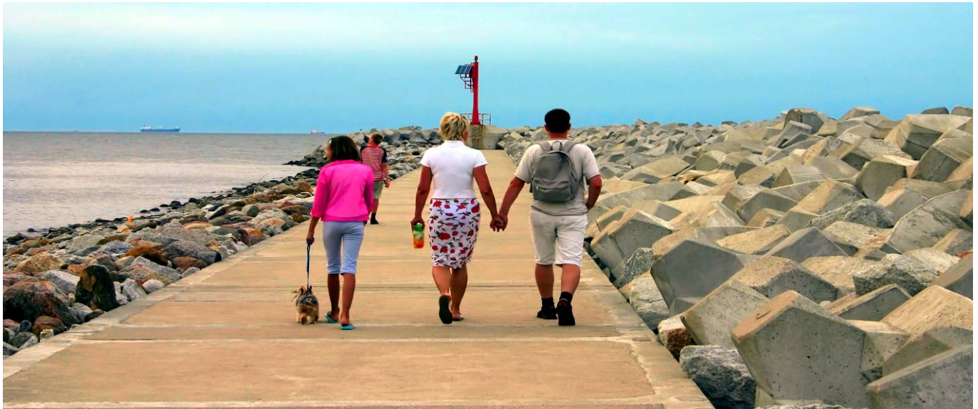
Kystsikring. Betonblokkene forhindrer at kysten bliver ædt af havet.
